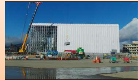
焼却炉解体のための覆い作業(気仙沼ブロック) (平成26年1月 気仙沼市)
