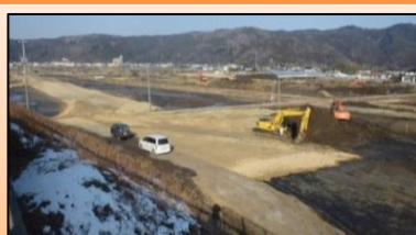
新渡波西地区 造成状況(石巻市)
