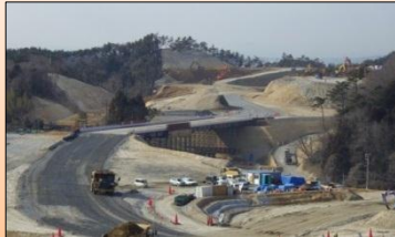
野蒜北部丘陵地区造成工事状況 (東松島市)
