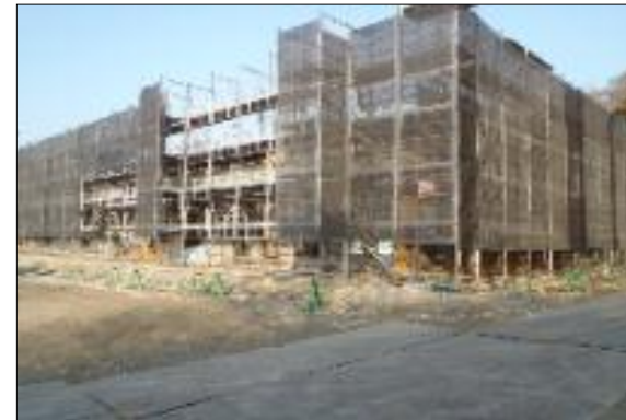
災害公営住宅(県受託;石巻市吉野町一丁目地区)建設状況
