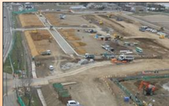
下増田地区造成工事状況 (名取市)
