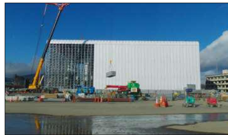
焼却炉解体のための覆い作業 (気仙沼ブロック) (平成26年1月 気仙沼市)
