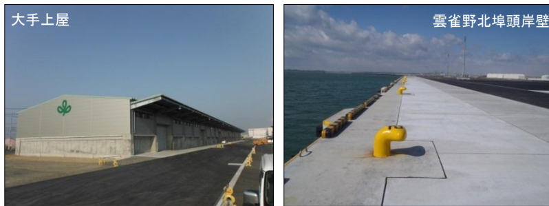
仙台塩釜港石巻港区の復旧状況 (石巻市)
