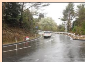
全面通行止めの解除後
