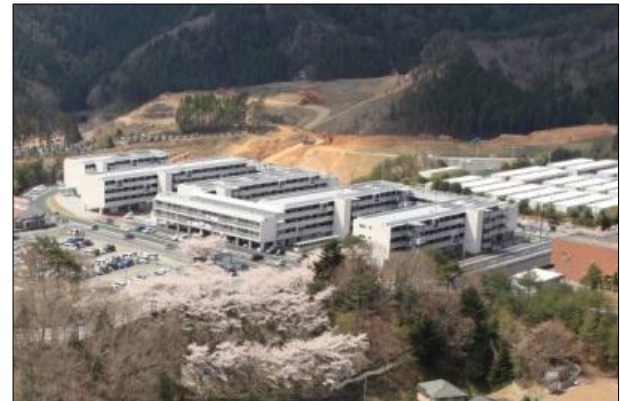
災害公営住宅整備状況(女川町:町民陸上競技場跡地地区)
