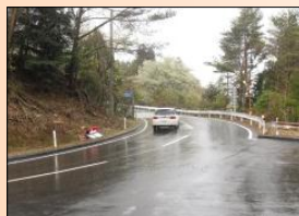
全面通行止めの解除後
