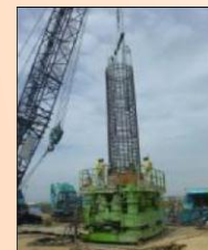
常磐線の本体工事に着手
