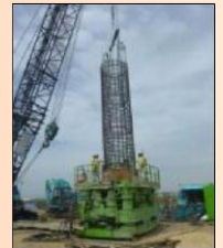
常磐線の本体工事に着手
