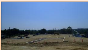
代ヶ崎浜立花地区造成完了(七ヶ浜町)
