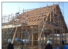
県産材を利用した 災害公営住宅
