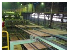
復旧した合板工場
