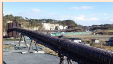
野蒜丘陵地区ベルトコンベア稼働状況(東松島市)
