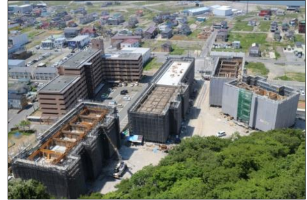
災害公営住宅整備状況(石巻市吉野町一丁目地区)
