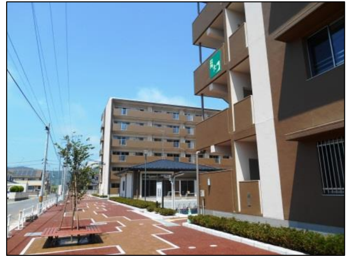
災害公営住宅整備状況(石巻市黄金浜北地区)
