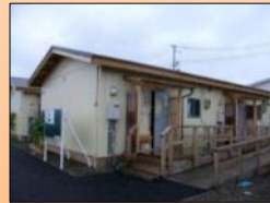
プレハブ仮設住宅(名取市)
