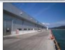
復旧が進められている 石巻魚市場
