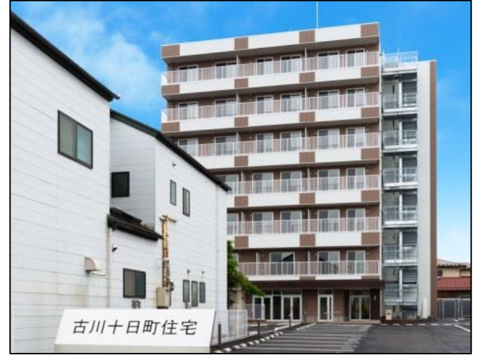
災害公営住宅整備状況 (大崎市古川十日町地区)
