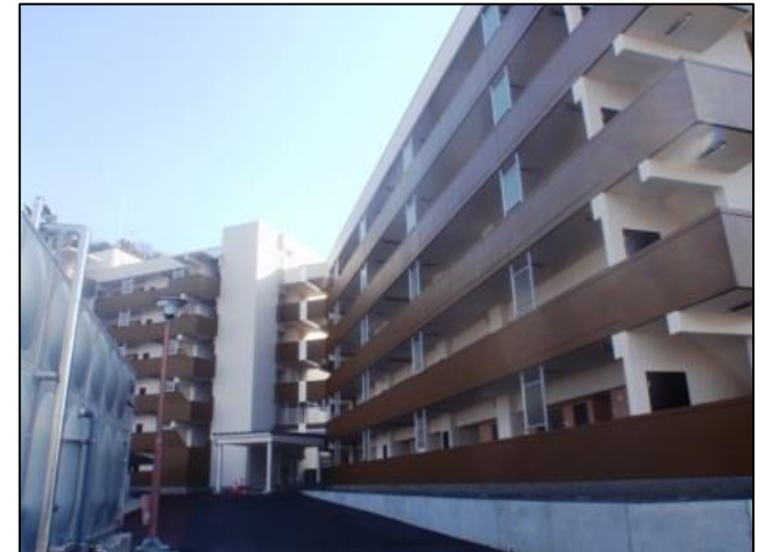
災害公営住宅整備状況 (石巻市吉野町地区A棟)
