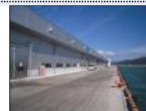
復旧が進められている 石巻魚市場
