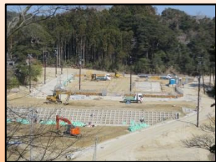
寒風沢地区造成工事状況 (塩竈市)
