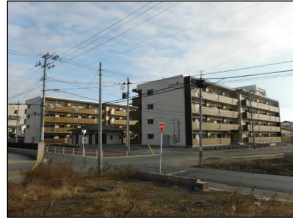
災害公営住宅整備状況 (石巻市黄金浜地区)
