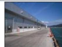
復旧が進められている 石巻魚市場
