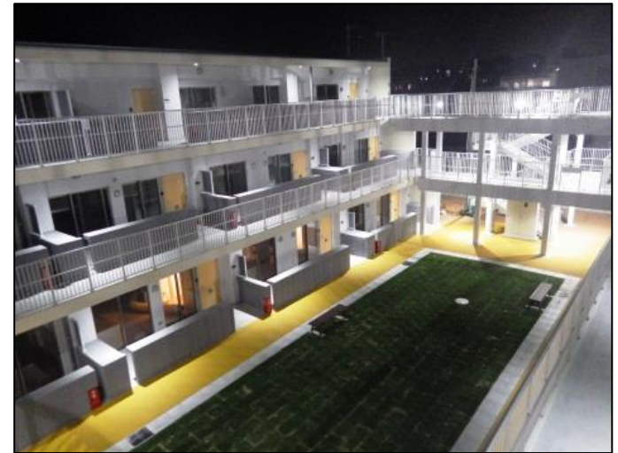
災害公営住宅整備状況(七ヶ浜町菖蒲田浜地区)
