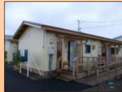
プレハブ仮設住宅(名取市)
