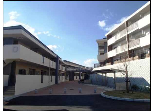
災害公営住宅整備状況(七ヶ浜町花洲浜地区)
