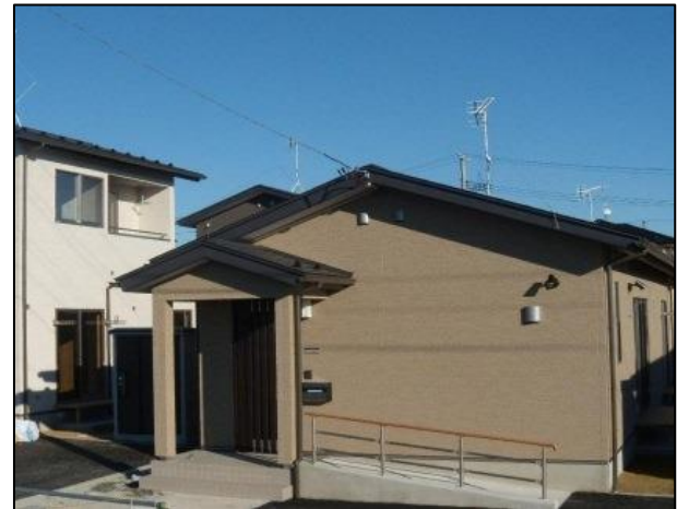
災害公営住宅整備状況(東松島市小野駅前区画整理地内南)
