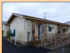
プレハブ仮設住宅(名取市)
