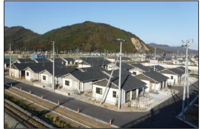
災害公営住宅整備状況(石巻市新渡波地区C街区)
