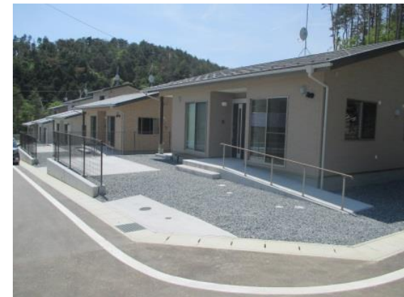
災害公営住宅整備状況(女川町指ヶ浜地区)
