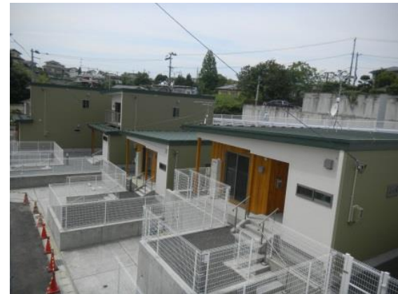
災害公営住宅整備状況(塩竈市伊保石地区(2期))
