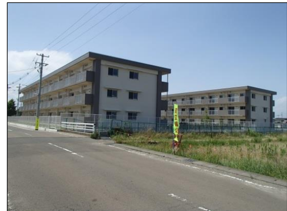
災害公営住宅整備状況(仙台市六郷地区)
