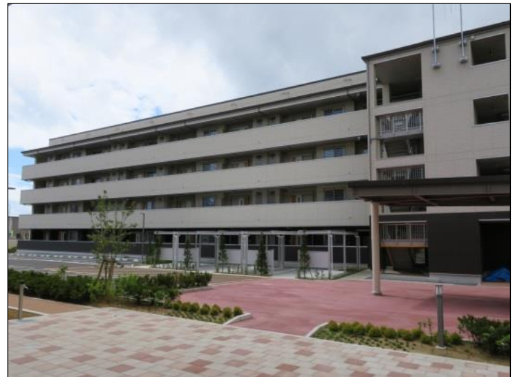
災害公営住宅整備状況(南三陸町志津川東地区(3街区))
