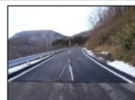
復旧した林道 高倉線(大和町)
