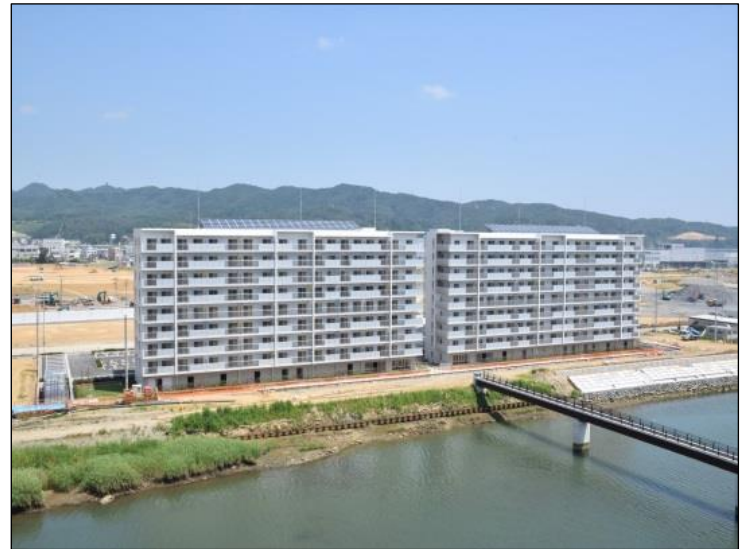
災害公営住宅整備状況(気仙沼市南気仙沼(内の脇)地区)
