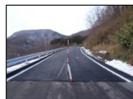
復旧した林道 高倉線(大和町)
