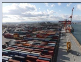
仙台塩釜港(仙台港区) 高砂コンテナターミナル
