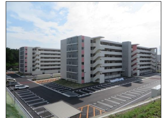
災害公営住宅整備状況(塩竈市清水沢地区(西工区))
