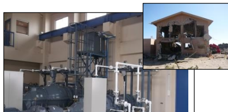
復旧した花笠第2排水機場 (山元町)
