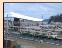
運行が再開された石巻線(女川駅)
