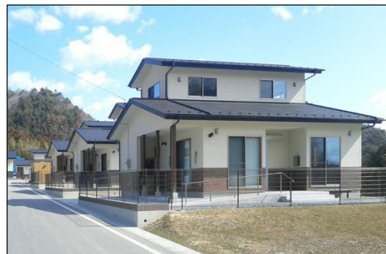
災害公営住宅整備状況 (女川町竹浦地区)
