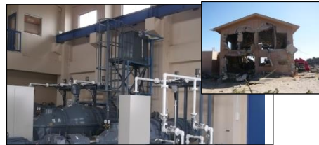
復旧した花笠第2排水機場 (山元町)
