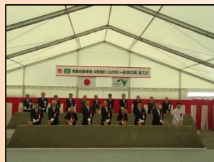
着工式(鉄入れ)
