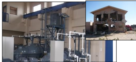
復旧した花笠第2排水機場 (山元町)
