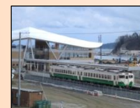
運行が再開された石巻線(女川駅)
