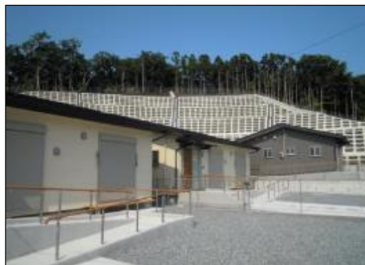
災害公営住宅整備状況 (石巻市佐須地区)
