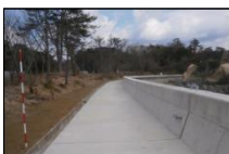
復旧した防潮護岸 (東松島市宮戸)
