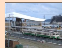
運行が再開された石巻線 (女川駅)
