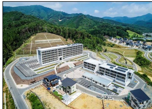
災害公営住宅整備状況 (女川町ずい道地区)
