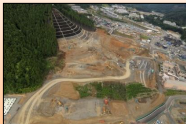
堀切山地区(女川町)
