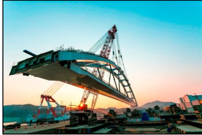
架設作業が完了した気仙沼大島大橋(橋脚間の長さは297m)
