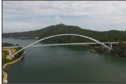
架設作業が完了した気仙沼大島大橋(橋脚間の長さは297m)
