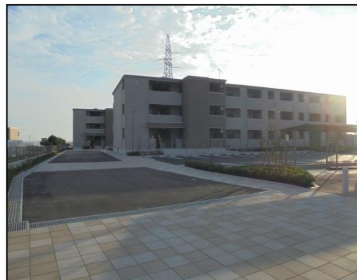
災害公営住宅整備状況 (石巻市広淵)
