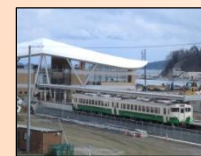
運行が再開された石巻線(女川駅)
