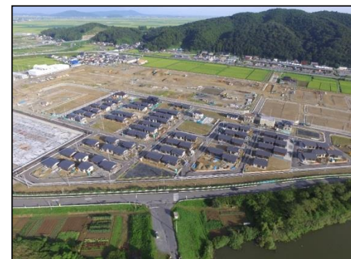
災害公営住宅整備状況 (石巻市河北地区1工区)
