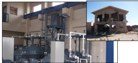
復旧した花笠第2排水機場(山元町)
