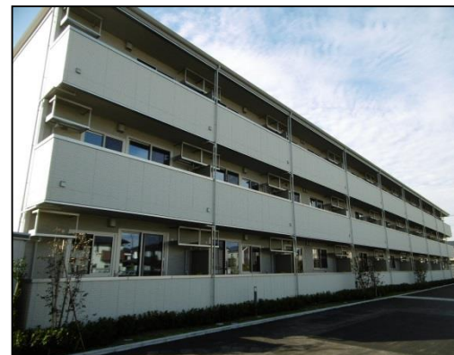
災害公営住宅整備状況 (石巻市蛇田字新東前沼)
