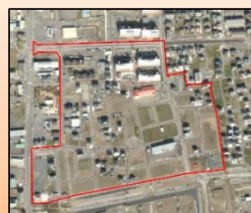
下釜第一地区(石巻市)
