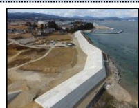
復旧した防潮堤 (気仙沼市崎野)
