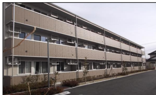
災害公営住宅整備状況 (石巻市中坪地区)
