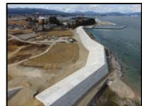
復旧した防潮堤 (気仙沼市崎野)
