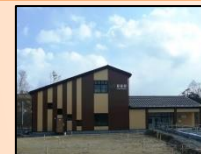
野蒜駅(新駅舎)
