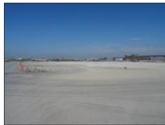
焼却炉解体後の状況 (石巻ブロック)
