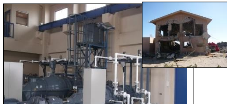
復旧した花笠第2排水機場 (山元町)
