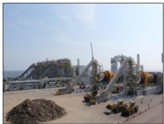
焼却炉稼働時の状況 (石巻ブロック)
