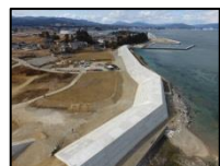
復旧した防潮堤 (気仙沼市崎野)
