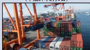
仙台塩釜港(仙台港区) 高砂コンテナターミナル
