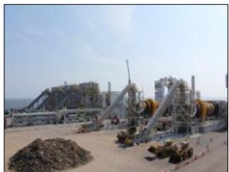
焼却炉稼働時の状況 (石巻ブロック)
