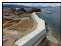
復旧した防潮堤 (気仙沼市崎野)
