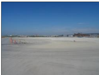
焼却炉解体後の状況 (石巻ブロック)
