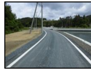
復旧した林道 日向貝線 (気仙沼市)
