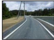
復旧した林道 日向貝線 (気仙沼市)
