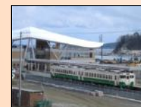
運行が再開された石巻線 (女川駅)
