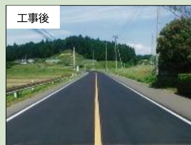
内陸部の舗装補修事例（国）113号
