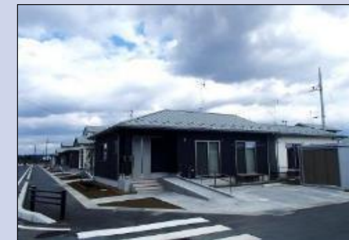
柳の目西地区(東松島市)
