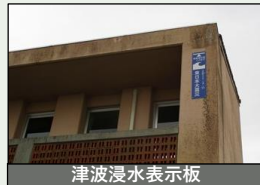
津波浸水表示板
