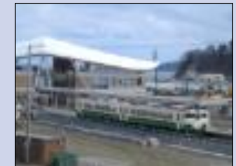
運行が再開された石巻線 (女川駅)
