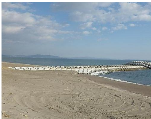
大曲海岸 完成状況
