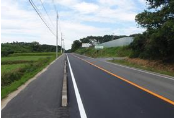
(主) 塩釜吉岡線 復旧状況
