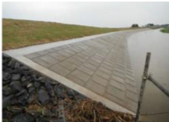
(一) 旧迫川 完成状況
