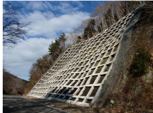
(一) 牡鹿半島公園線 復旧状況
