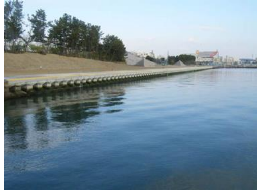
雷神護岸Ⅰ復旧状況
