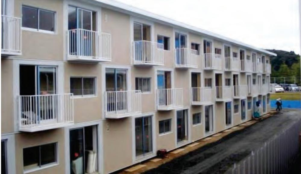
図 2- 94 コンテナを利用した多層型応急仮設住宅 女川町運動公園野球場地区
