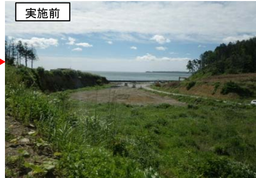
海岸高潮対策事業 中島海岸：宮城県気仙沼市 実施内容：護岸工（防潮堤）
