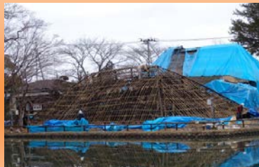
解体中の屋根
