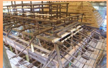
柱の組み上げ工事
