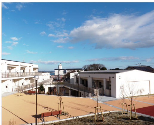
12/9 全地区で災害公営住宅が完成(七ヶ浜町)
