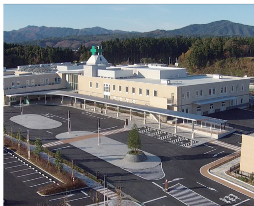
12/14 南三陸病院・総合ケアセンター南三陸 開院(南三陸町)※
