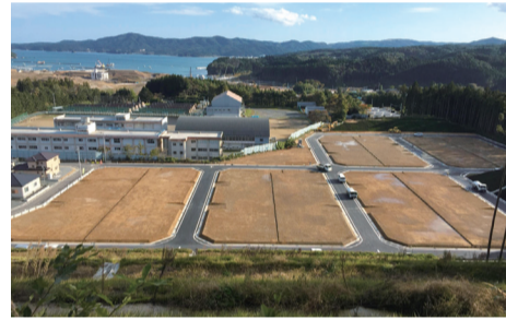
南三陸町志津川西団地(東工区)
