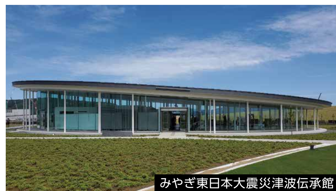
みやぎ東日本大震災津波伝承館
