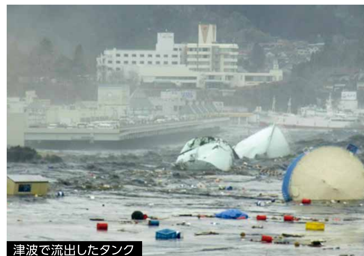
津波で流出したタンク
