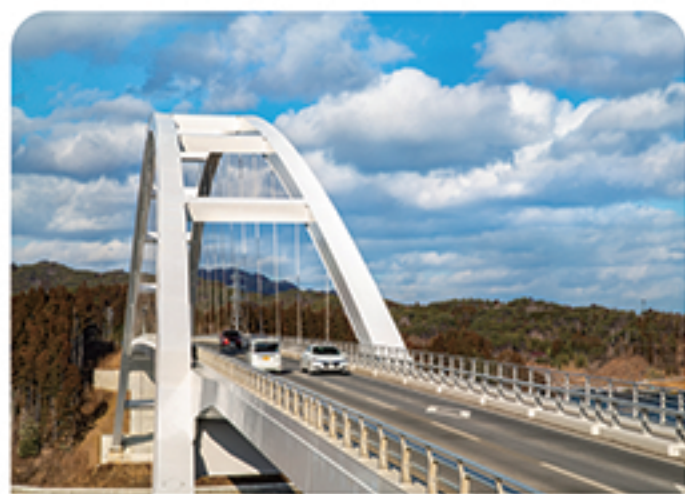
平成31年4月、復興のシンボルとして整備が進められてきた気仙沼大島大橋(愛称:鶴亀大橋)が開通しました。
