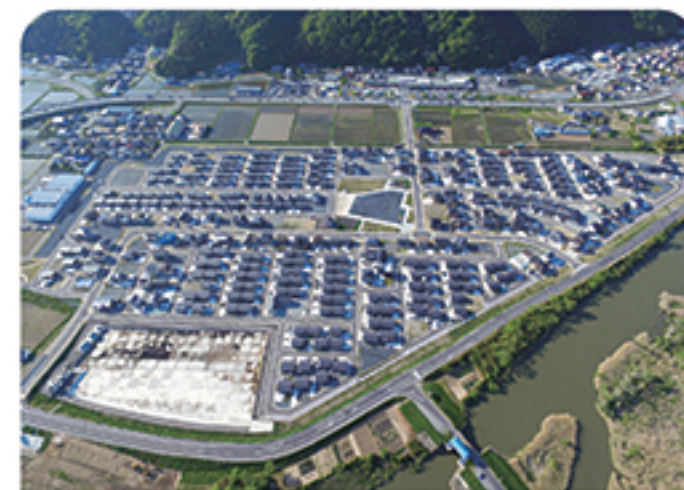
県内全ての地区で造成工事等に着手、住宅等建築工事が可能となりました。(写真：石巻市の二子団地)
