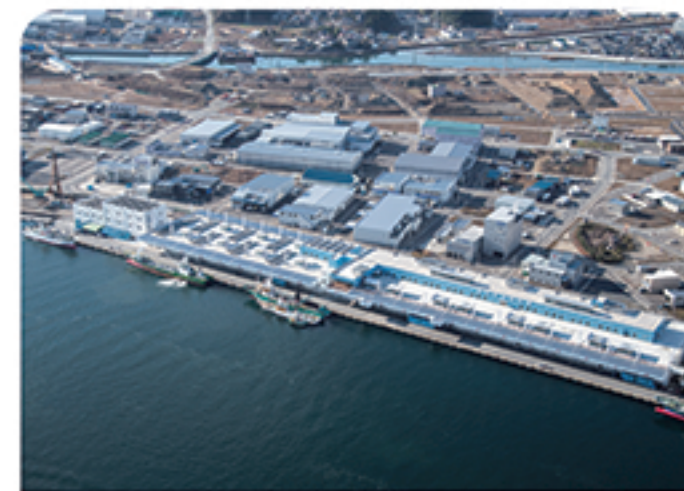
復旧した気仙沼市魚市場の供用が開始されました。
