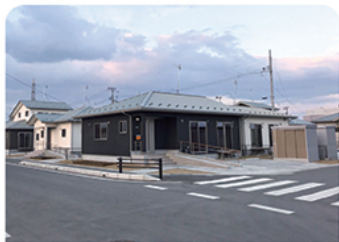
東松島市の「柳の目西地区」の災害公営住宅が完成し、県内全ての災害公営住宅整備事業が完了しました。
