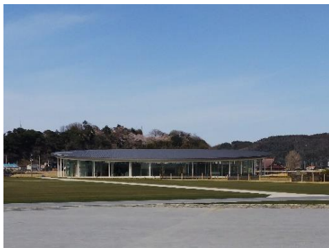
みやぎ東日本大震災津波伝承館
