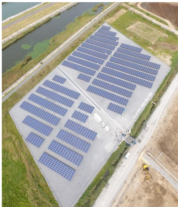
発電所の全景（右上が富士川及び北上川）
