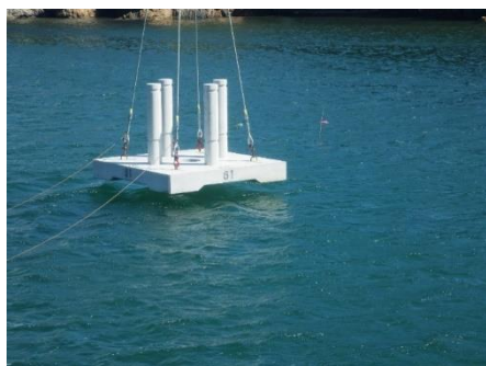
増殖礁ブロック設置状況
