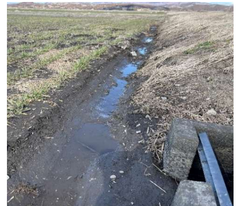
図11 停滞水が溜まる明渠 (落水口前に土が盛り上がっている)
