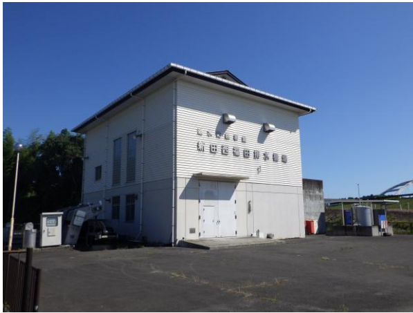
▲ 新田西福田排水機場
