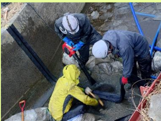
▲水路目地補修作業の様子
