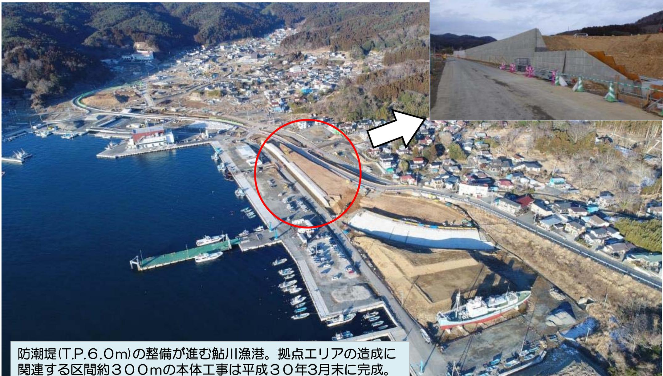
防潮堤(T.P.6.0m)の整備が進む鮎川漁港。拠点エリアの造成に関連する区間約300mの本体工事は平成30年3月末に完成。
