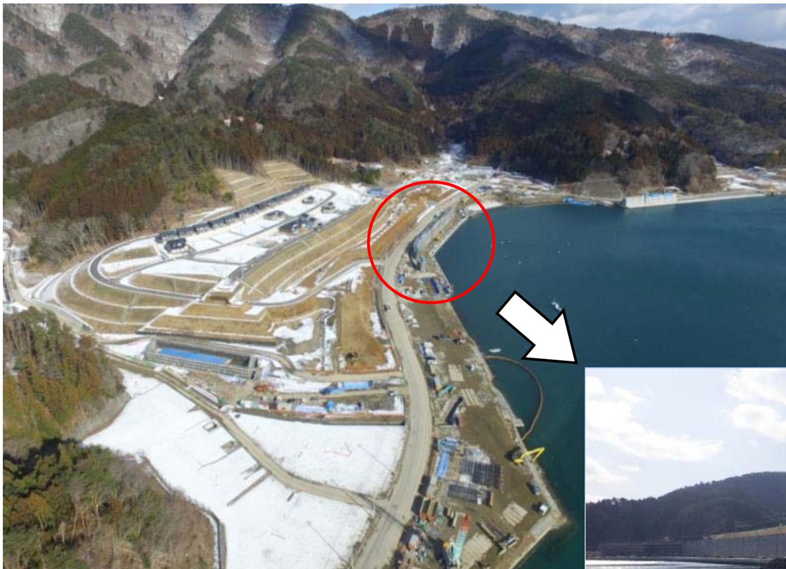
防潮堤(T.P.9.7m)の復旧が進む雄勝漁港。拠点エリアの造成に関連する区間約250mの本体工事は平成30年3月末に完成。
