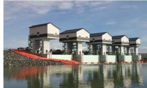
<仮設ポンプ配管(赤色)と長沼水門>
