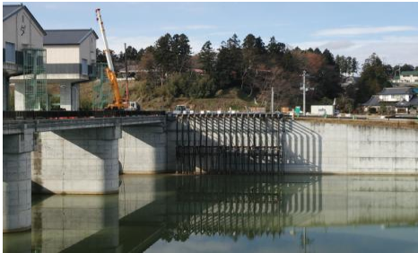
<仮設水中ポンプの設置状況>
