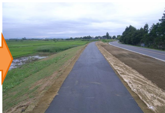
<復旧状況写真>
