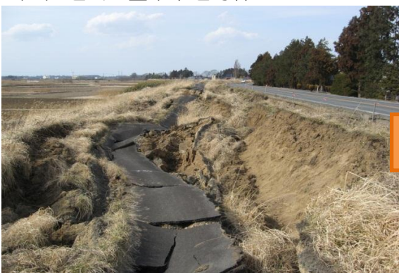
<3.11被災状況写真>
