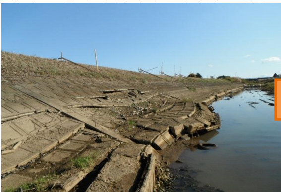
<3.11被災状況写真>
