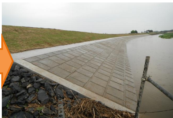
<復旧状況写真>
