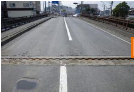
<3.11被災状況写真>
