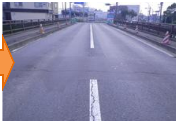
<復旧状況写真>
