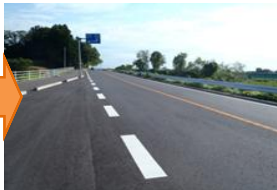
<復旧状況写真>
