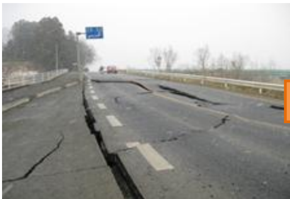
<3.11被災状況写真>
