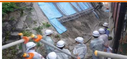
研修会の様子（丸森災害防除工事現場）
