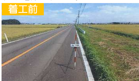
(主) 古川佐沼線 板倉歩道設置工事
