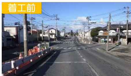
(主) 築館登米線外 寺池道路改良工事
