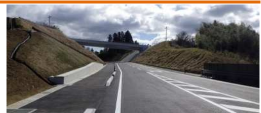
バイパスの完成状況(起点側(錦桜橋側)より撮影)
