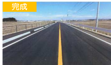
登米市南方町後屋敷待井地内 (令和2年3月完成)
