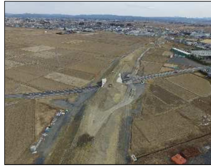
② 本線の盛土工事をしています。
