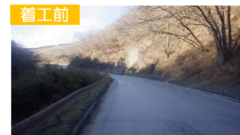
(一) 志津川登米線 下羽沢災害防除工事
