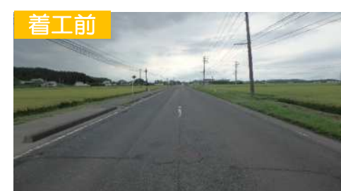
(国) 346号 米川外舗装補修工事
