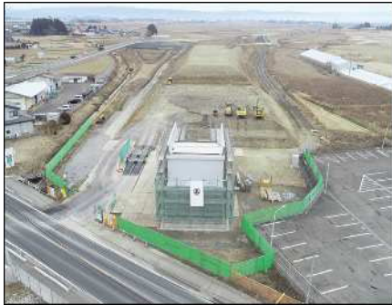
① 加賀野高架橋の下部工を作っています。
