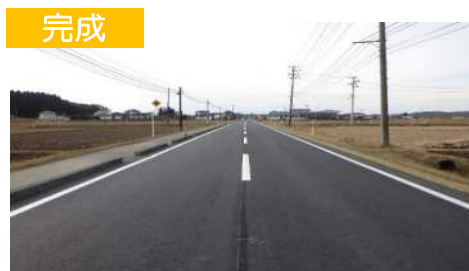
登米市東和町米川地内外 (令和2年2月完成)
