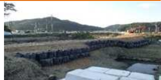
石貝川(津山町柳津)の応急復旧状況
