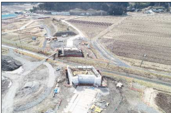
④ 新大瀬橋の下部工を作っています。
