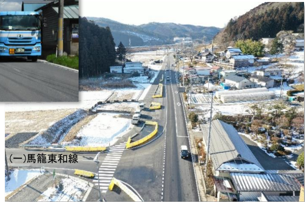
部分供用開始後の状況
