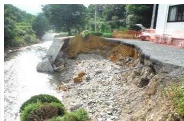
(一) 東和薄衣線 東和町錦織 道路法面崩落
