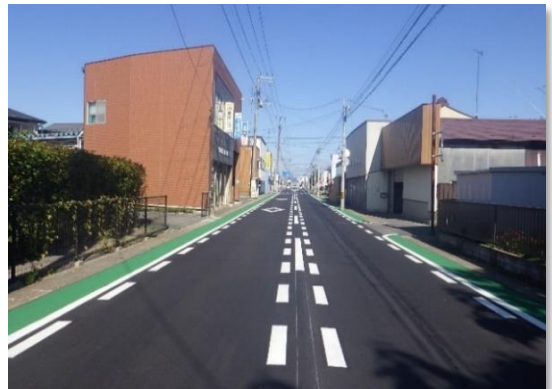
補修後の状況
