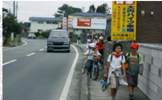
改良前の状況
