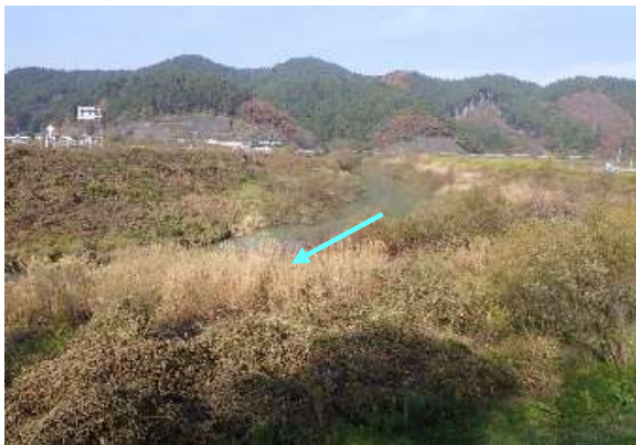
(南沢川の状況写真・施工前)
