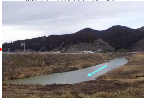
(南沢川の状況写真・施工後)
